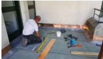
Abdichten der Hauswand
